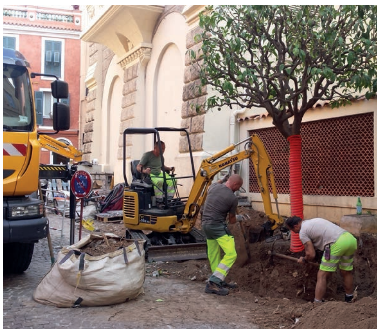
Protection du tronc et racines de l'arbre pendant travaux.
