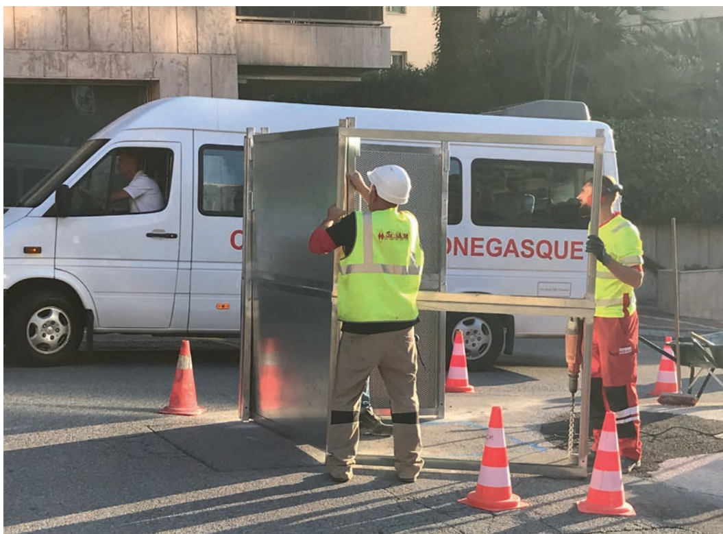
Cabine de travail et de protection sonore répondant aux demandes de gestion, contrôle et réduction du bruit du aux chantiers.
