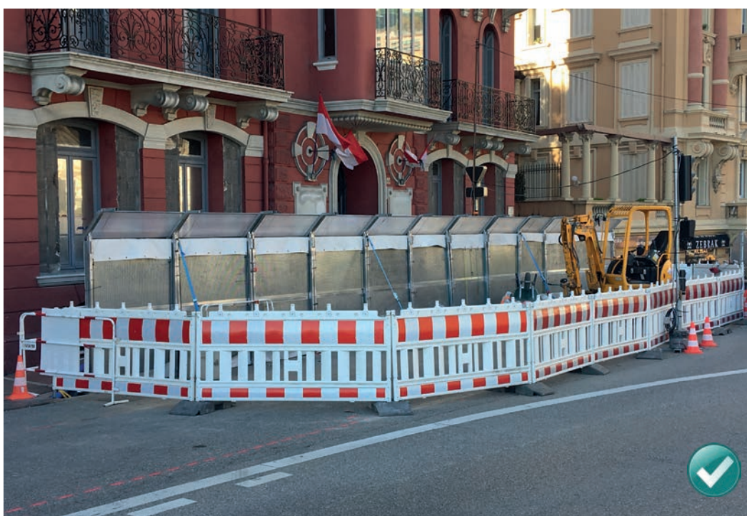
Chantier encadré par des barrières occultantes et solidaires, sentiment de chantier bien tenu et propre.
