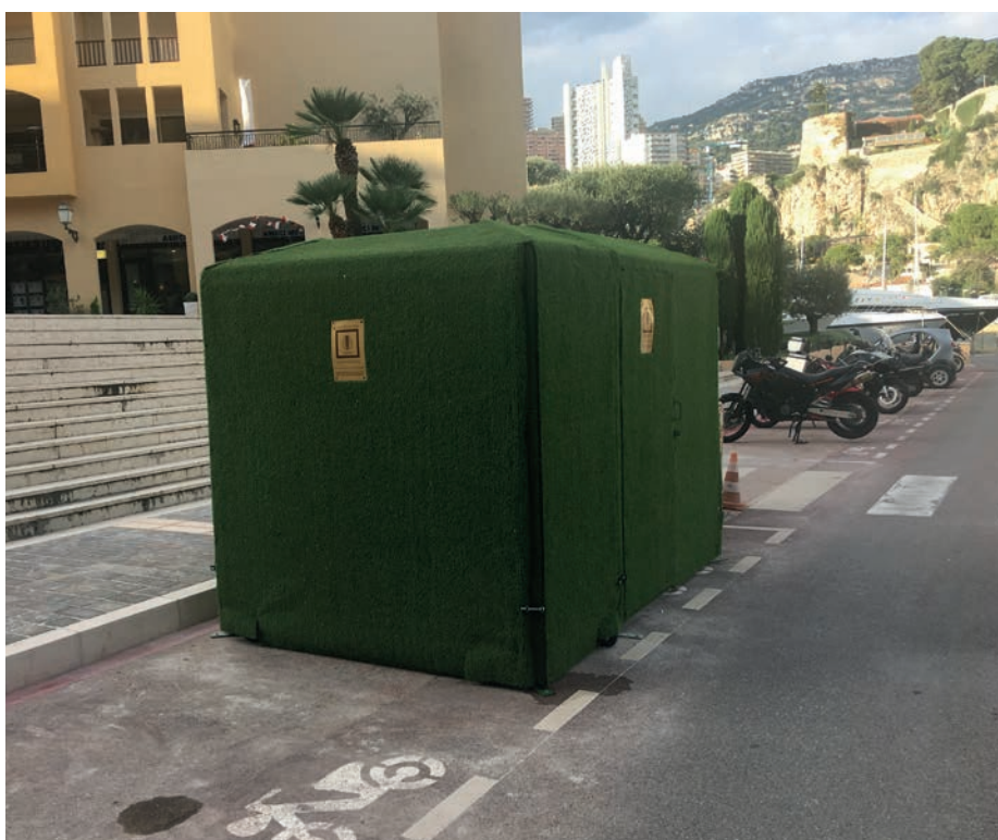
cabine de travail et de protection sonore répondant aux demandes de gestion, contrôle et réduction du bruit du aux chantiers.
